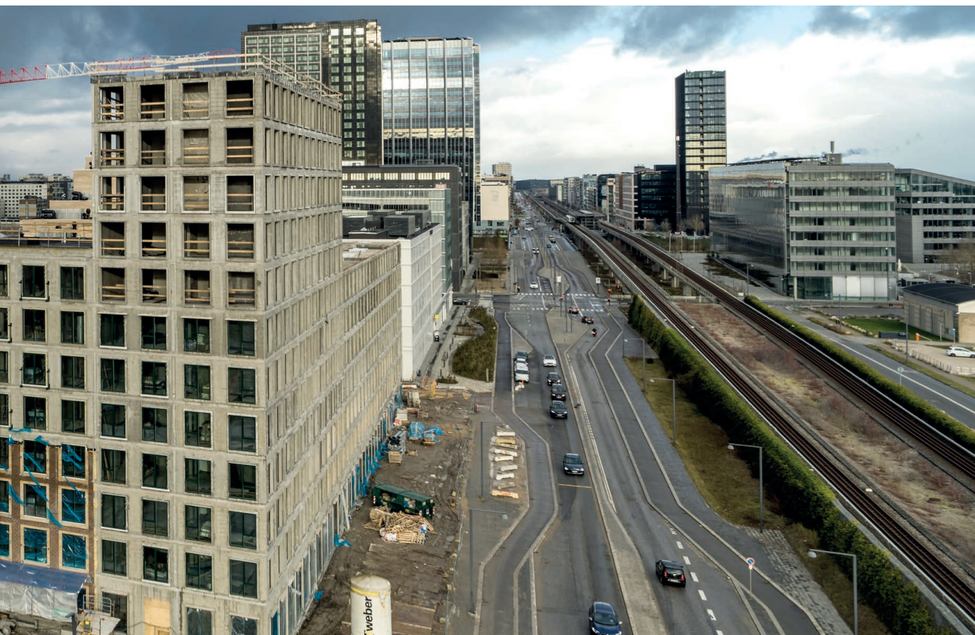
Byggeriet af Kanalgaarden, december 2023.
